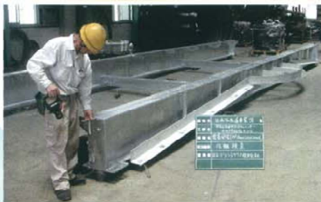
下水処理場 覆蓋用梁
