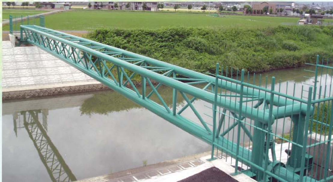
逆三角ワレントラス補剛形式水管橋(S-1塗装)
