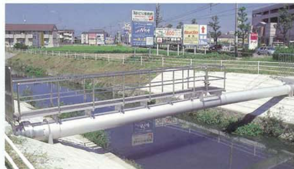
SUS304L 500Aパイプビーム形式水管橋
